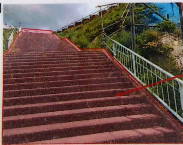
【既設構造物等取壊し】
