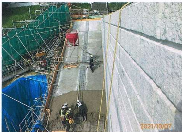
階段構築作業
