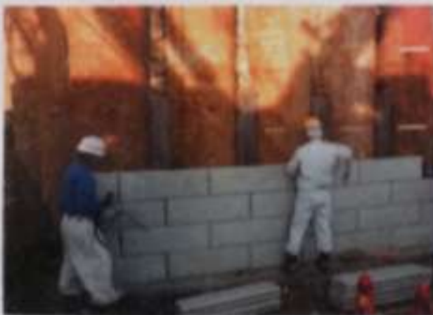
壁面工構築作業
