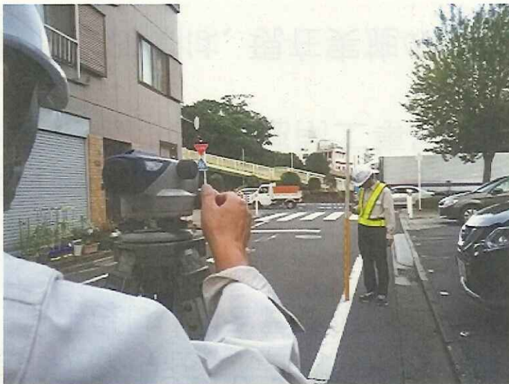
地表面沈下測定
