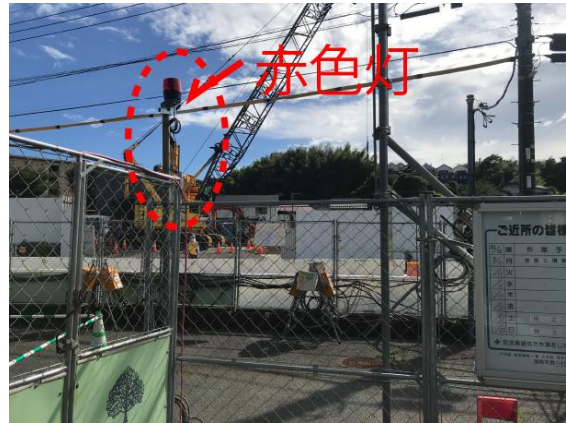
仮設階段下の赤色灯
