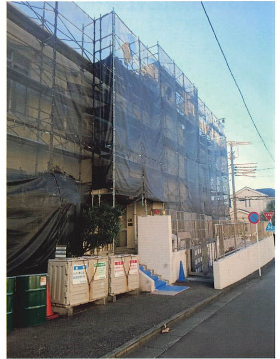
作業中の桂台地域ケアプラザの外観
