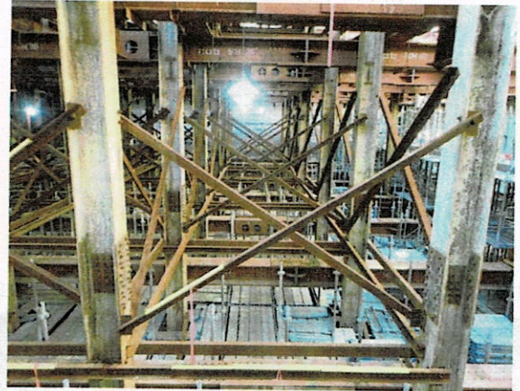
立坑内写真（側壁構築状況） R3.12.13撮影
