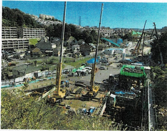
全景写真（仮橋工） R3.12.13撮影
