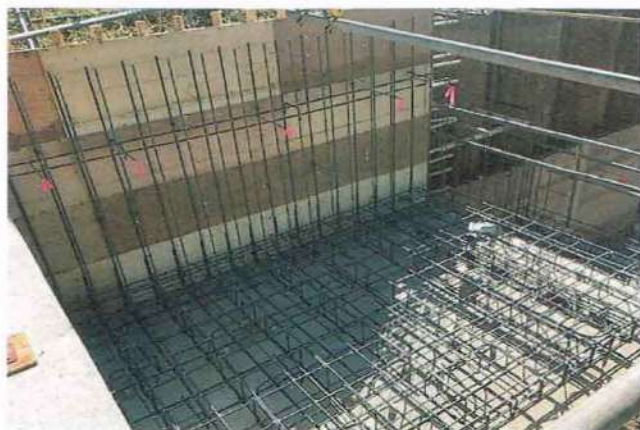
鉄筋・型枠作業
