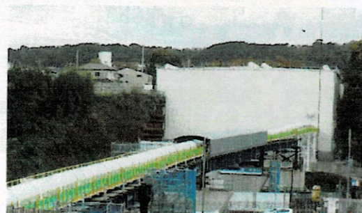
ベルトコンベア設置状況
