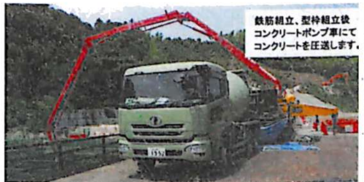
コンクリート打設作業(イメージ図)
