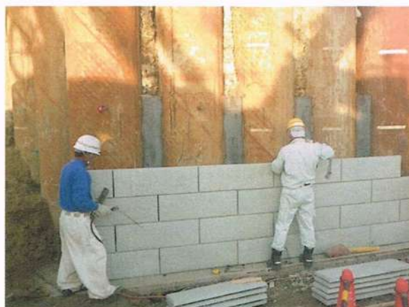
壁面工構築作業
